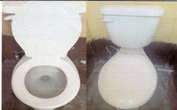
Foto 13: Sustitucion de tapaderas en baño Módulo 8
