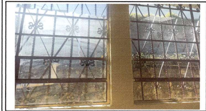
Foto 7: Sustitución de vidrios en ventanales. Módulo 1
