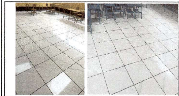
Foto 9: Sustitución de piso de cemento liquido por cerámico. Módulo 1 y 2
