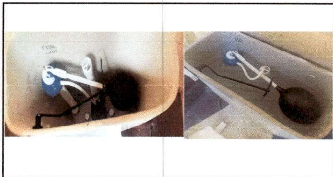
Foto 12: Sustitución de accesorios inodoro para área de baños Módulo 8
