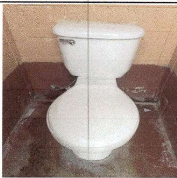
Foto 14: Sustitución de inodoro en baños . Módulo 8
