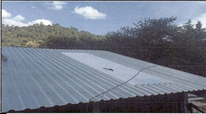
Foto 1: Sustitucion de lamina troquelada aluzinc Módulo 1
