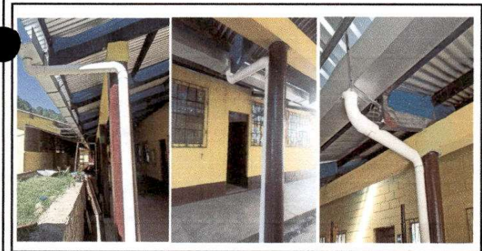
Foto 11: Sustitución y reparación de bajadas de agua pluvial con tubo PVC Módulo 7
