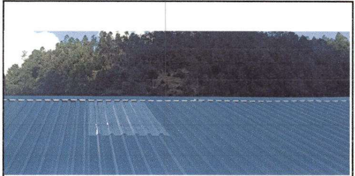
Foto 2: Sustitucion de Capotes por capotes de lámina aluzinc Módulo 1
