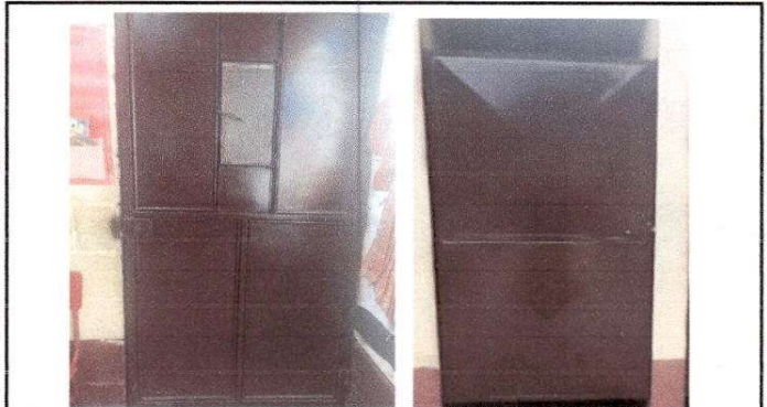
Foto 4: Mantenimiento de puertas de metal en 9 clases y 6 baños. Módulo 4
