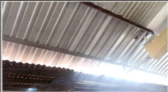
Foto 3: Sustitución de estructura de soporte de metal por metal en corredores de la escuela. Módulo 3
