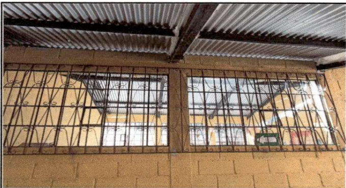
Foto 15: Fabricación e instalacion de balcones para protección del aula. Módulo 2
