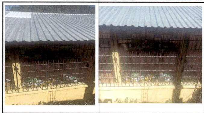
Foto 8: Mantenimiento de balcones en 9 clases. Módulo 6
